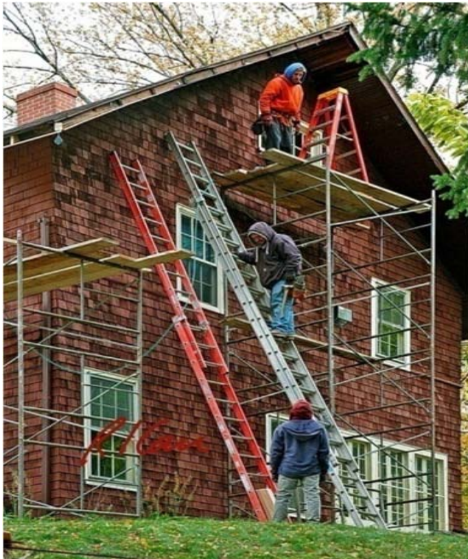
شکل ۲۷- تکیه استقرار نردبان در شیب زمین
